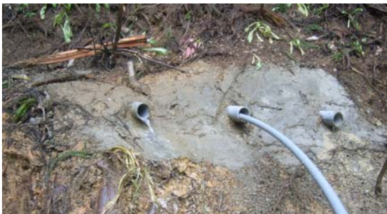
写真-5 上段の横ボーリング工実施直後の湧水状況
