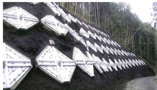
写真-6 アンカー工(鋼製受圧板併用)の施工完了後
